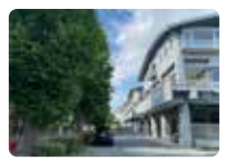
「第1回よこすか景観賞」を受賞。校舎と平作川が一体化した開放感ある景観が評価された。
